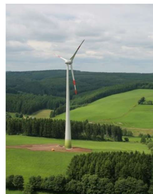
Slika 32: Vetrnica z instalirano močjo 3 MW, višine stebra od 78 do 138 m, premer rotorja 82 m. (Vir: Vetrna turbina)
