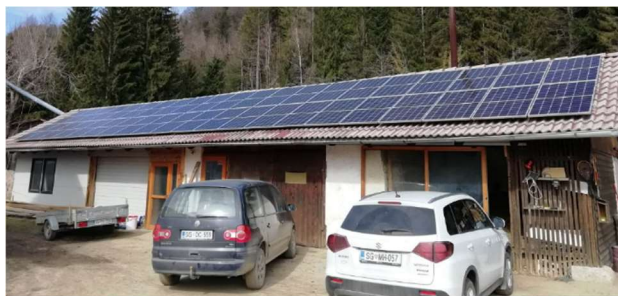
Slika 15: Sončna elektrarna 13,5 kW na Sv. Antonu na Pohorju. (Vir: Roškar)
