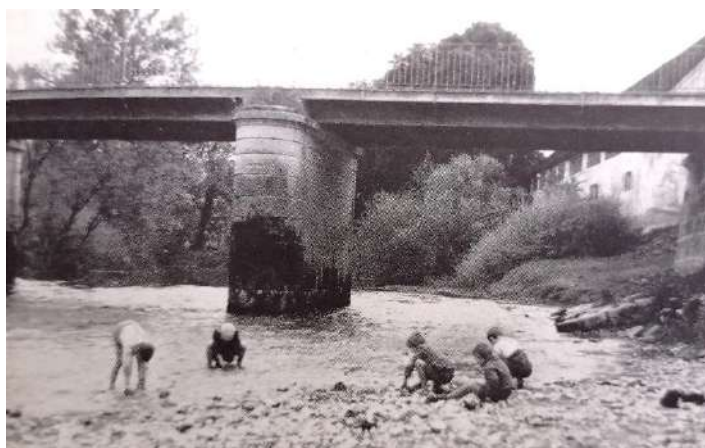
Slika 10: »Enajsta šola« pod mostom
