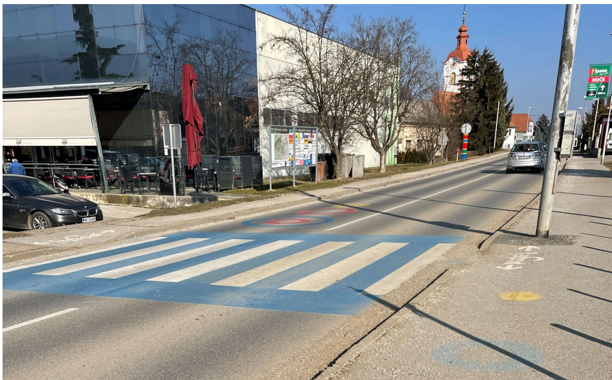
Slika 11: Modro beli prehod za pešce z dodatno talno poslikavo, Spodnje Hoče, 24. januar 2023.
