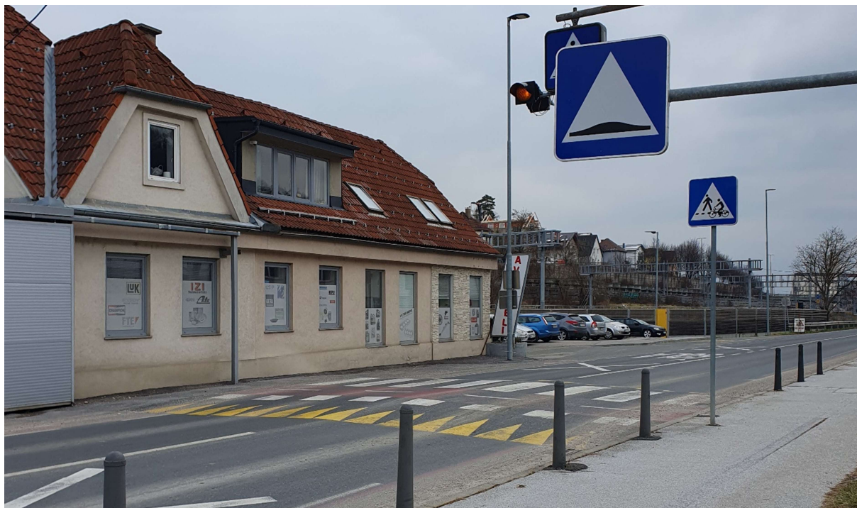
Slika 10: Primer prehoda na cestnem odseku, Šentiljska cesta, Maribor, 1. marec 2023.
