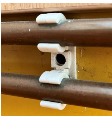
Slika 15: Objemke, s katerimi so pritrjene radiatorske cevi na steno
