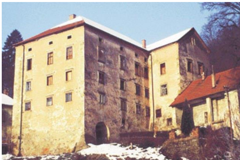
Slika 8: Dvorec Strmol pred obnovo v samostojni Republiki Sloveniji. (vir: https://grajska-restavracija-strmol.si/wp-content/uploads/2019/02/Dvorec-Strmol-nekoc.jpg )
