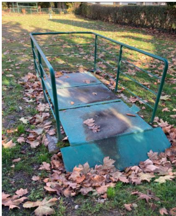
Slika 5: Vhod v zaklonišče - loputa (Vrbanska ul.)
