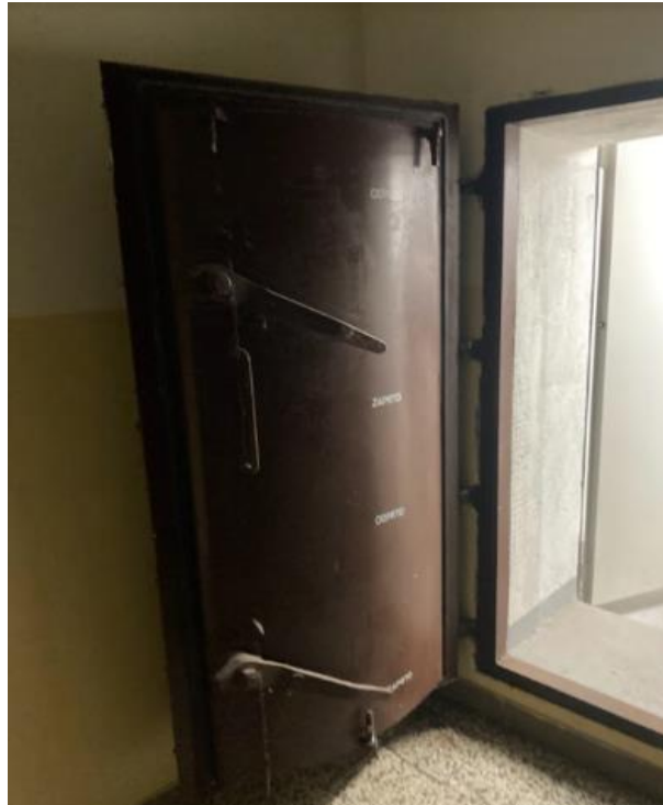
Slika 4: Vrata v zaklonišče (blok, Gregorčičeva ul.)
