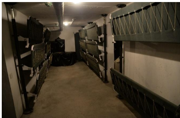
Slika 6: Vlaknena ležišča v prenovljenem zaklonišču – položaj, v katerem so dvignjena (blok, Kardeljeva ul.)
