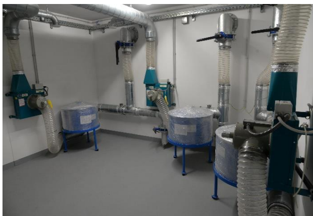
Slika 14: Naprave za prisilno zračenje (Medicinska fakulteta)
