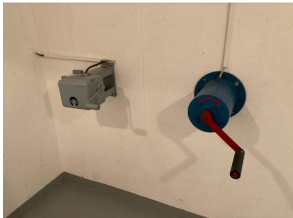
Slika 13: Naprava za ročno zračenje in ročno električno energijo (Trubarjeva ul.)
