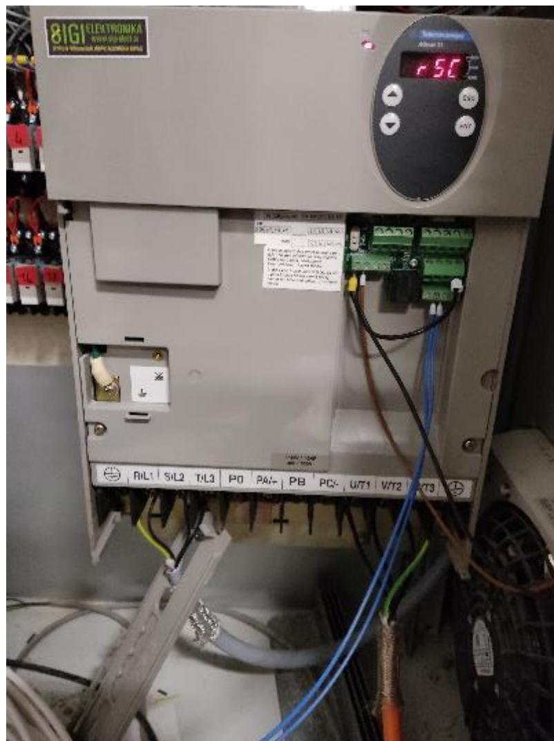
Slika 51: Frekvenčni regulator Altivar 31
