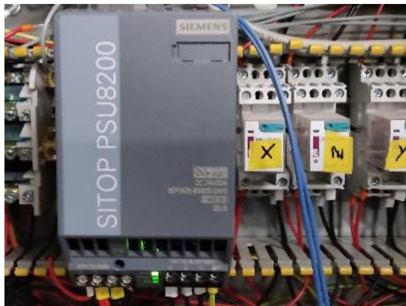
Slika 54: Napajalnik Siemens
