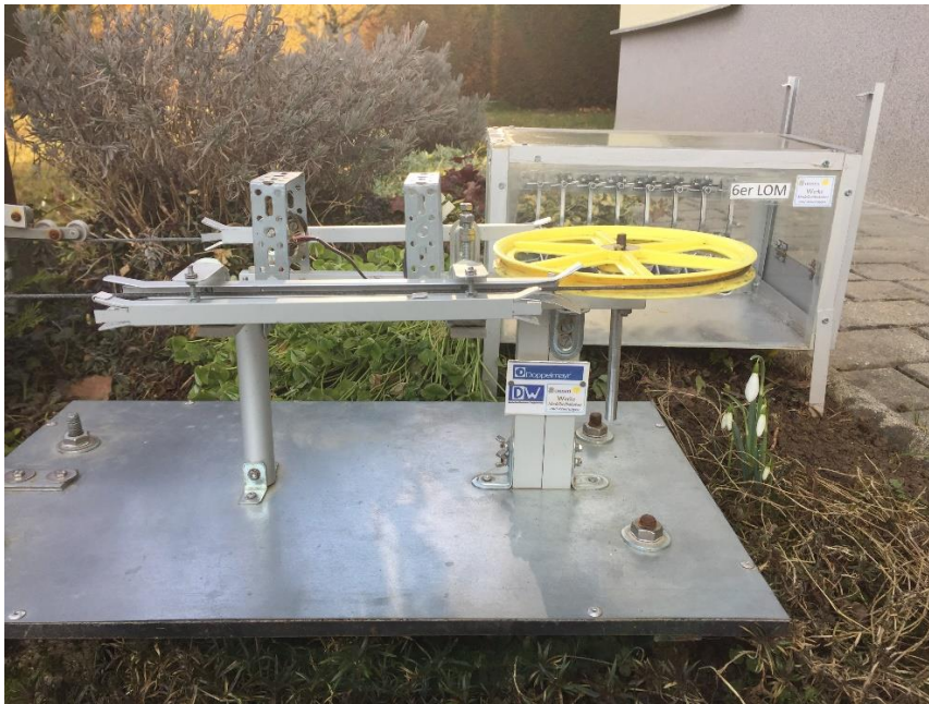
Slika 14: Konstrukcija spodnje postaje
