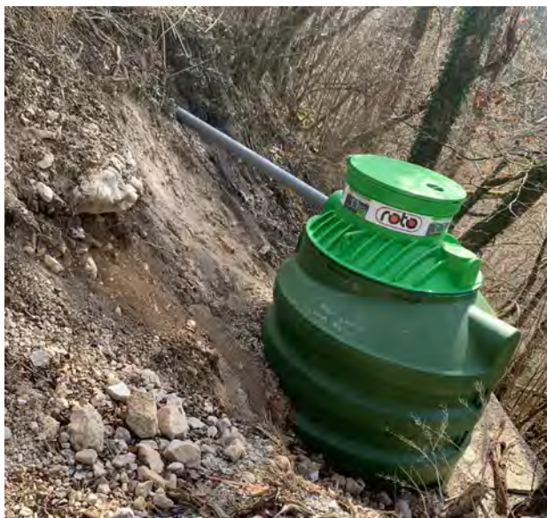
Slika 16: MKČN pri spodnji postaji nihalke (avtor: Matic Hrabar)
