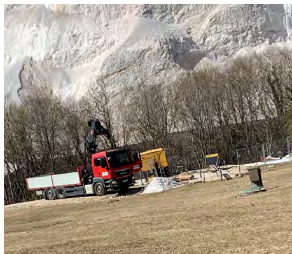
Slika 20: Gradbena dela na zajetju Iverje (avtor: Iza Škrtič)
