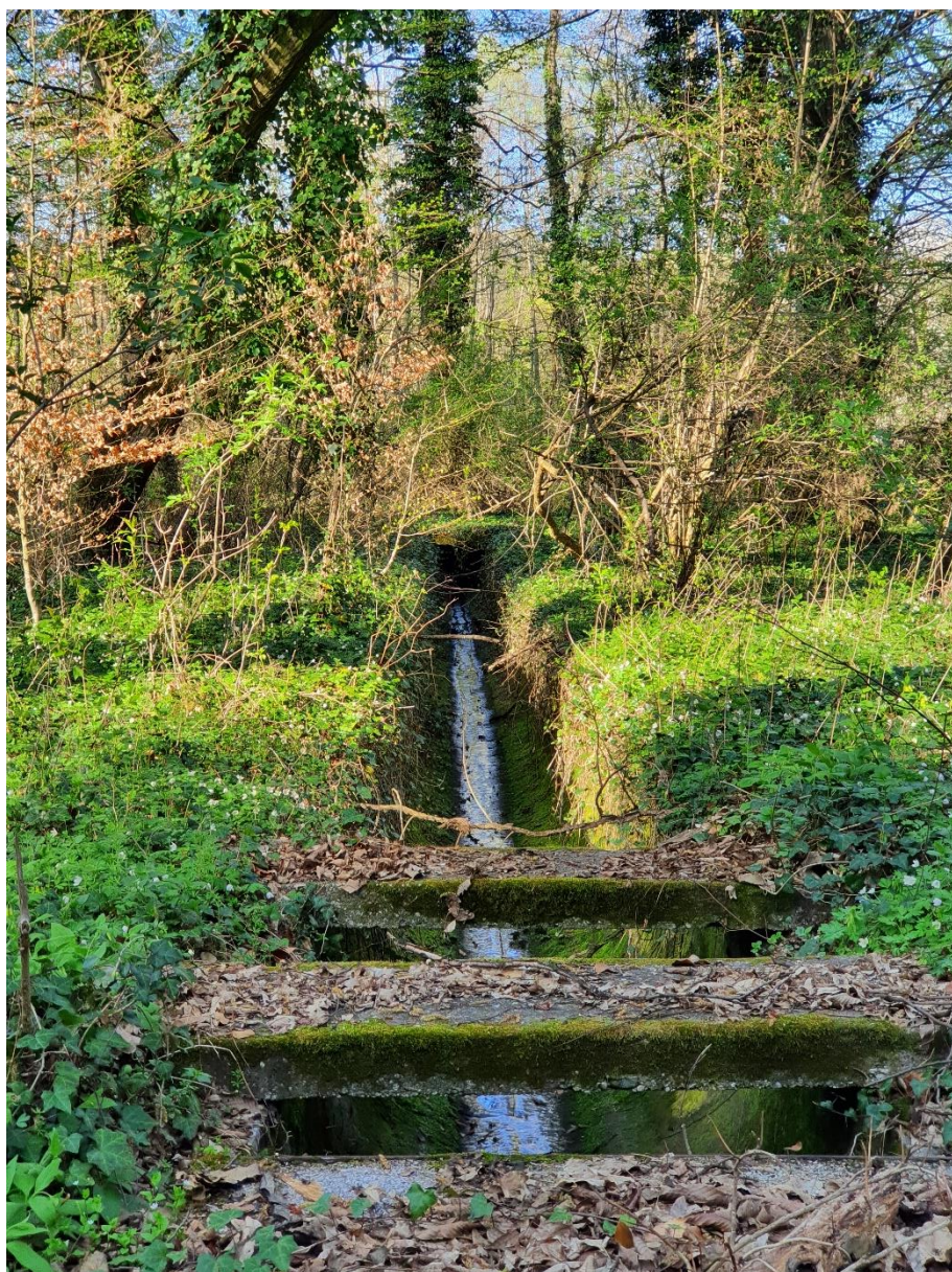
Priloga 5: Kanalizacijski iztok s Tezna v Stražunski potok (Vir: Urban Županič)
