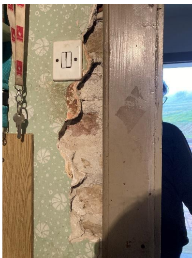
Slika 12: Odpadanje ometa od obodu vrat
