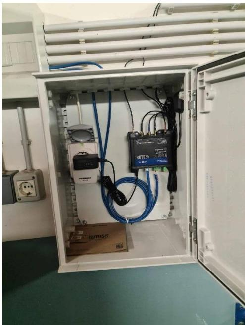
Slika 35: Razdelilnik z brezžičnim usmerjevalnikom v strojnici (vir: lasten vir)
