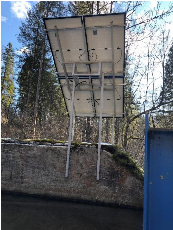
*Slika 25: Nosilna konstrukcija za PV panele (vir: lasten vir)*
