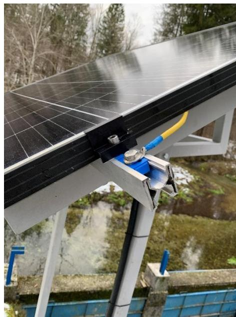
*Slike 29 in 30: Povezava stikalnega bloka na ozemljilo in ozemljitev PV panelov (vir: lasten vir)*
