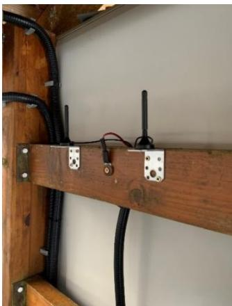
Slika 28: Nameščeni GSM anteni in temperaturni senzor (vir: lasten vir)
