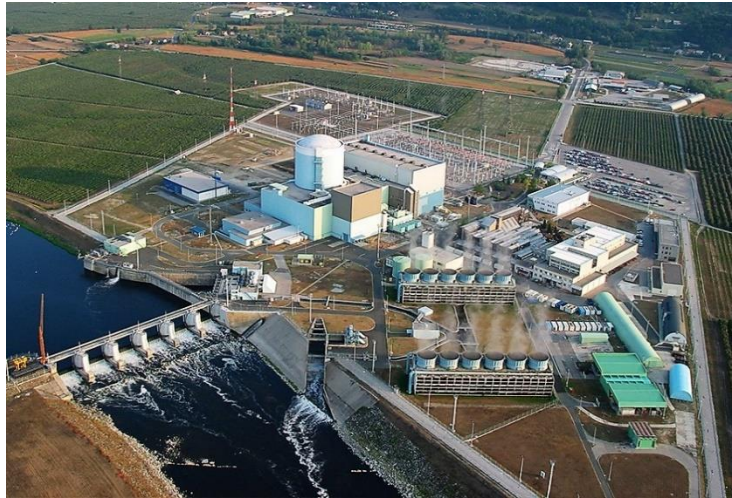
Slika 2: Jedrska elektrarna Krško
