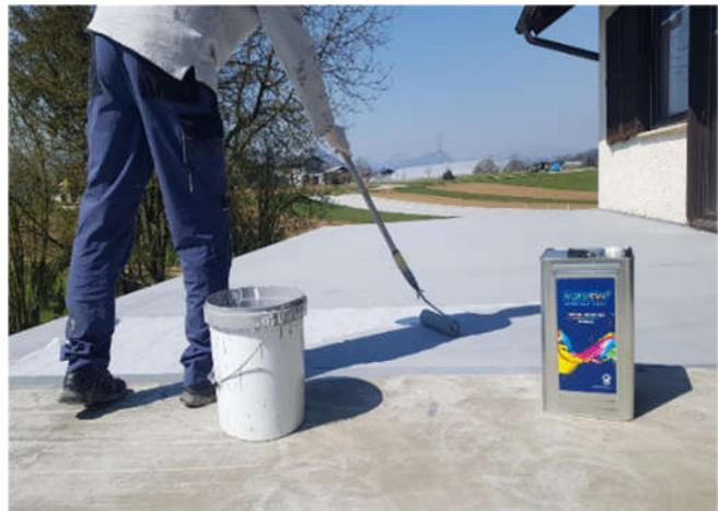
Slika 18: Poliuretanska membranska hidroizolacija
