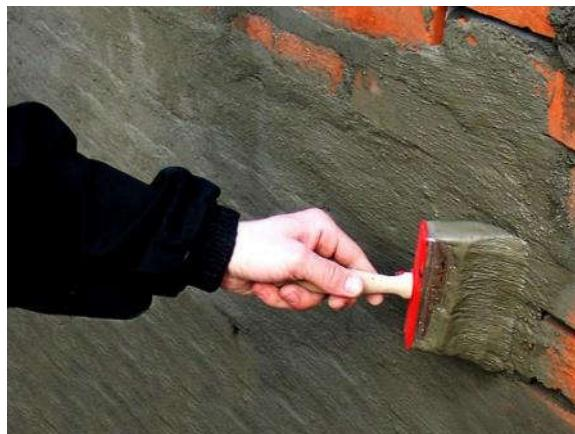
Slika 14: Hidroizolacija na osnovi cementa
