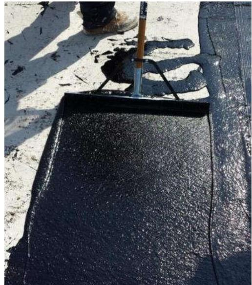
Slika 16: Bitumenski premaz
