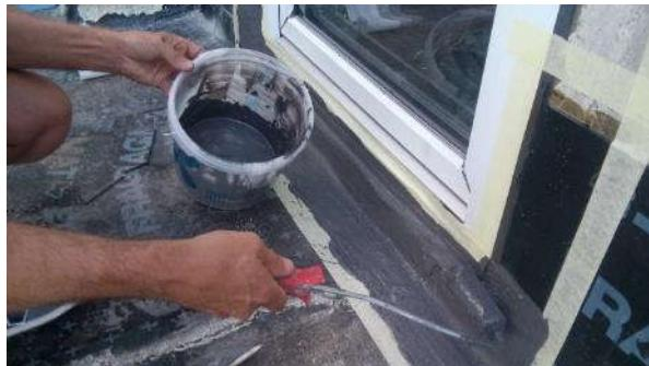
Slika 15: Tekoča hidro izolacijska membrana
