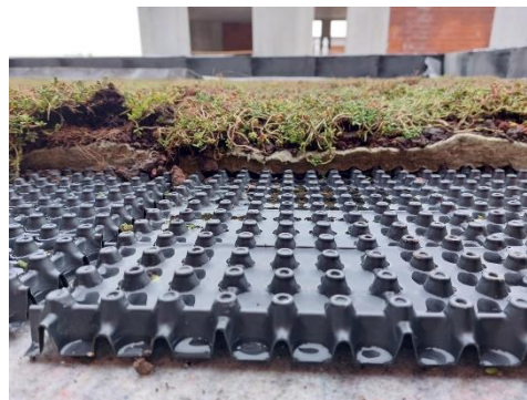
Slika 8: Prerez zelene strehe na enem od objektov
