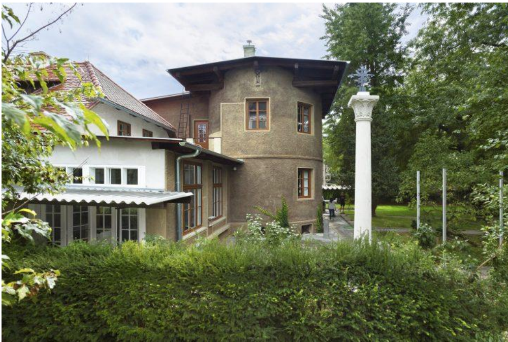
Slika 25: Polkrožni stolpič in odvečni steber Čevljarskega mostu
