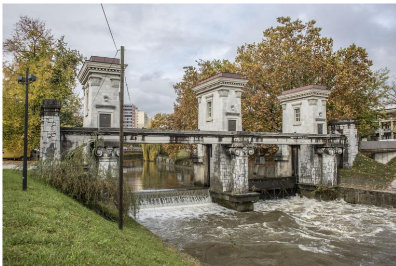
Slika 37: Zapornica na Ljubljanici
