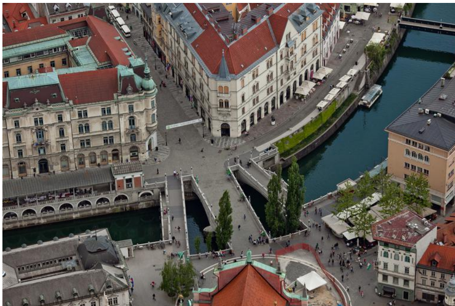
Slika 43: Tromostovje, pogled iz zraka
