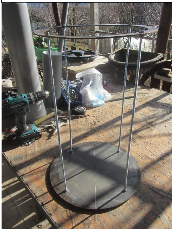
Slika 9: Izdelava jedra vertikalne vetrnice
