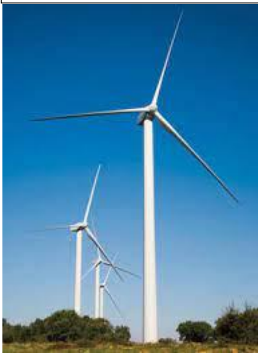
Slika 4: Horizontalna vetrna turbina s tremi lopaticami
