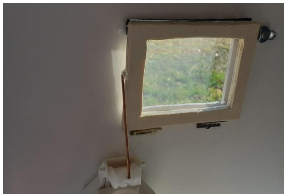
Slika 16: Vzvod za odpiranje oken
