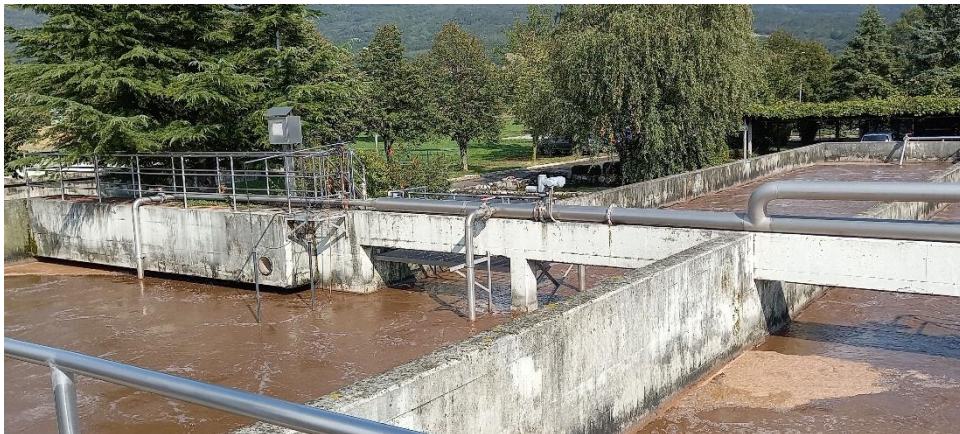
Slika 9: Biološko čiščenje vode (Foto: Ivana, Ajda, Izak)
