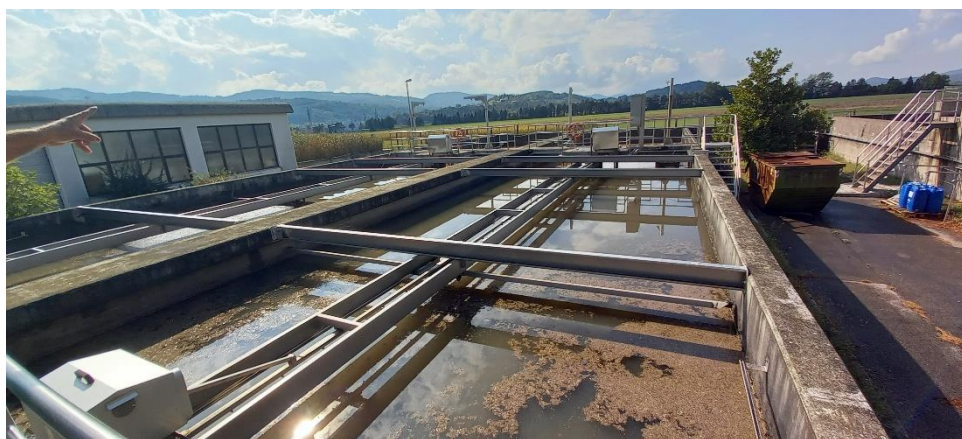
Slika 8: Denitrifikacijski bazen (Foto: Ivana, Ajda, Izak)
