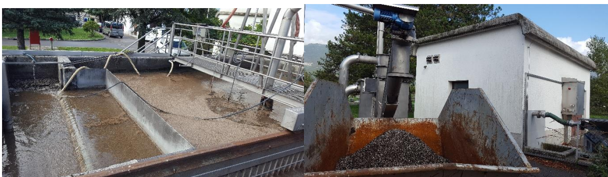
Slika 6: Maščobolovilec in pesek iz KČN (Foto: Ivana, Ajda, Izak)
