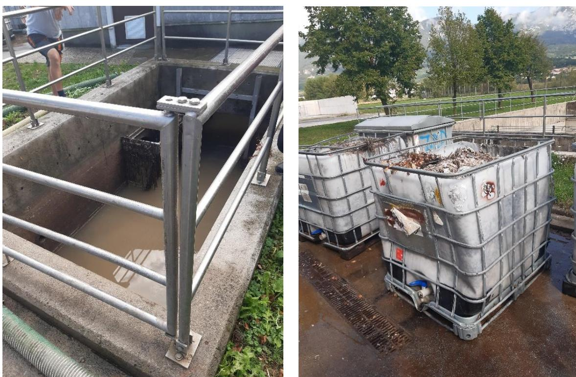
Slika 4: Bazen za mehansko čiščenje in odstranjeni odpadki po prvem mehanskem čiščenju
