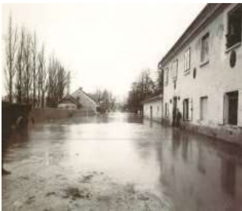
Slika 2: Stavba vojaške bolnišnice ob poplavi leta 1904 (na današnjem Gledališkem trgu) 38
