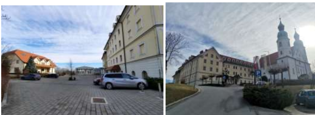
Sliki 63 in 64: Severna stran poslopja s parkiriščem in paviljonom (levo) in pogled na Jožefovo cerkev (desno)
