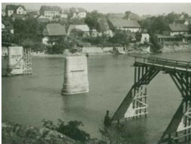
Slika 12: Gradnja mostu do Strme ulice leta 1946. 58
