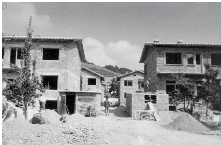
Slika 13: Gradnja naselja na Vinarski ulici. 67
