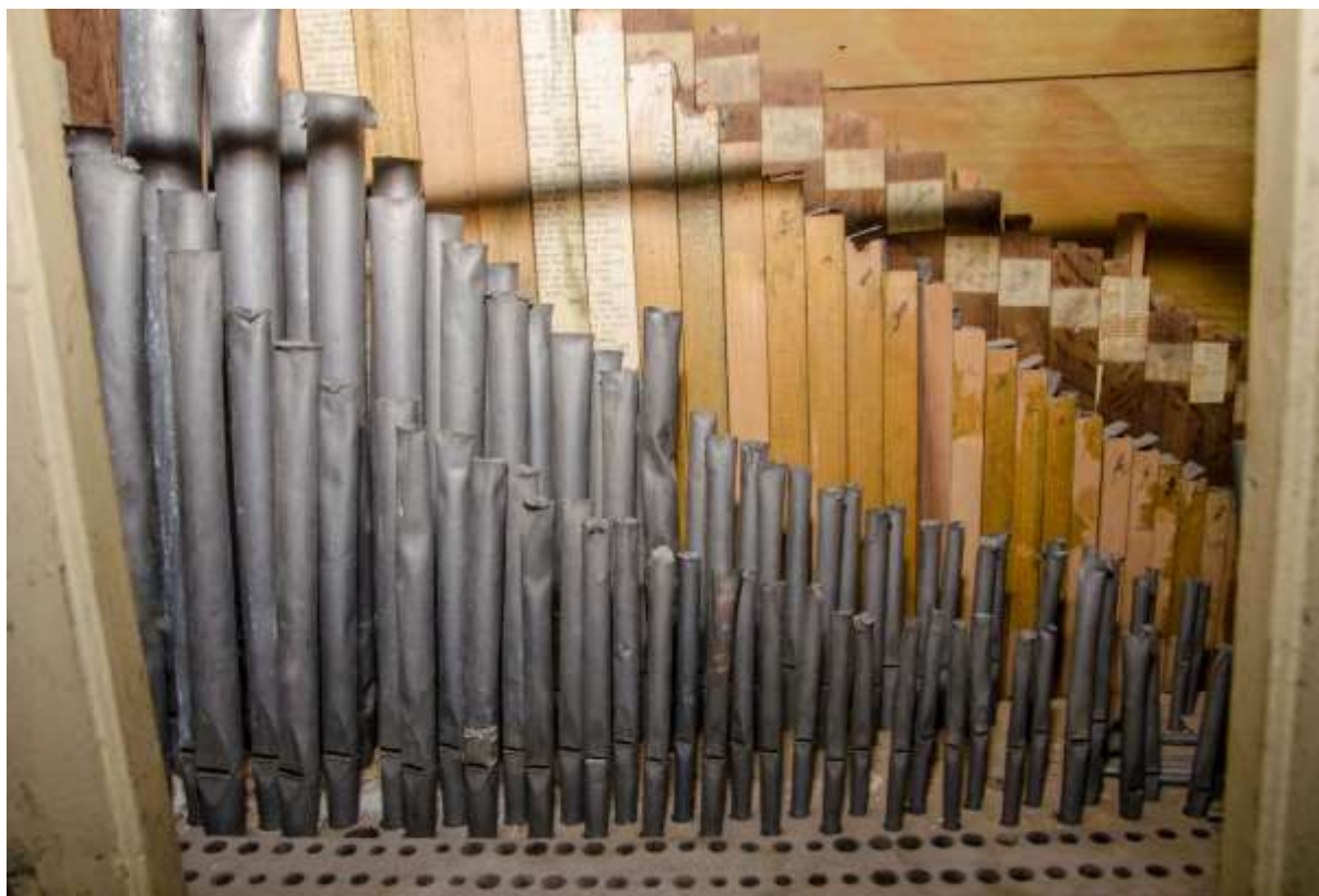
Slika 41: Močno poškodovane lesene in kovinske piščali
