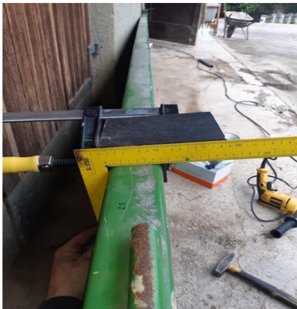
Slika 22: Montiranje nosilca na stranico (Osebni vir)
