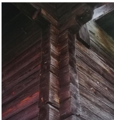
Slika 26: Zveza tesanih brun s preklopom
