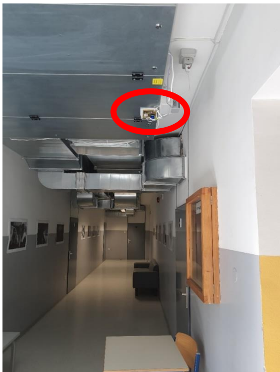
Slika 24: Merilni sistem za merjenje vlažnosti in temperature
