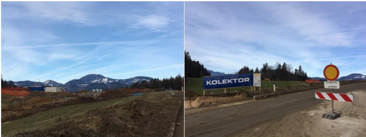
Slika 14: Začetek gradbenih del v Gaberkah, 30. 1. 2021 14
