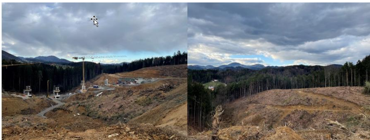
Slika 17: Gradnja v Gaberkah, 3. 4. 2021 17
