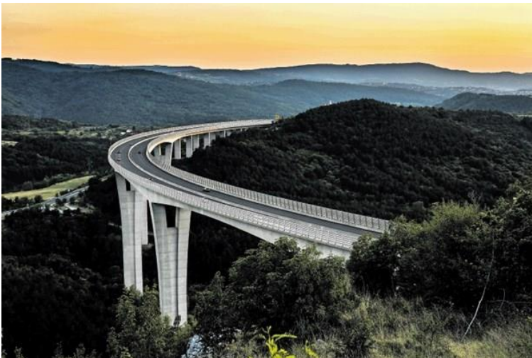
Slika 19: Viadukt Črni Kal
