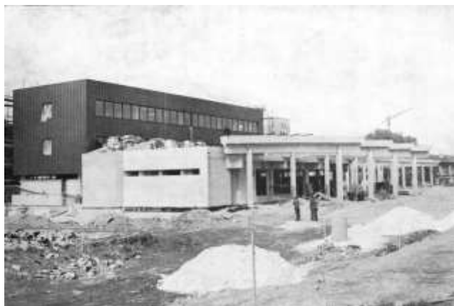
Slika 25: Gradnja nove avtobusne postaje 98
