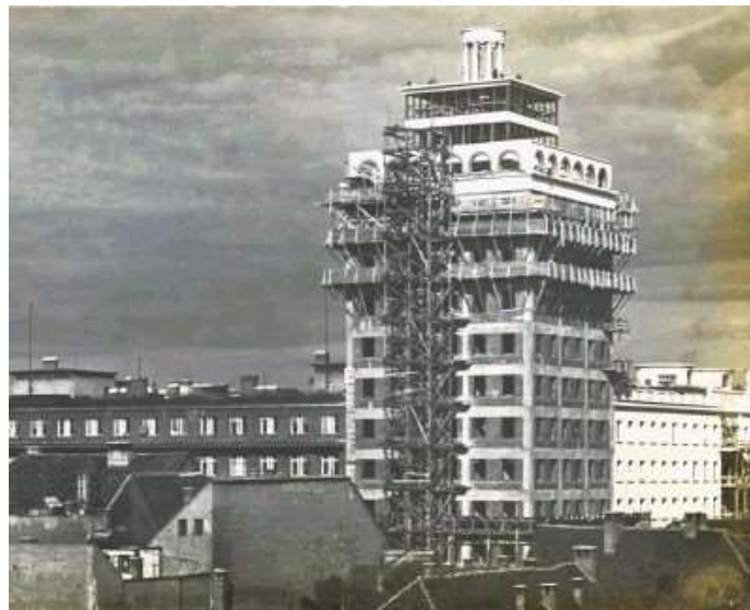
Slika 3 Nadgradnja nebotičnika - potresno varen
