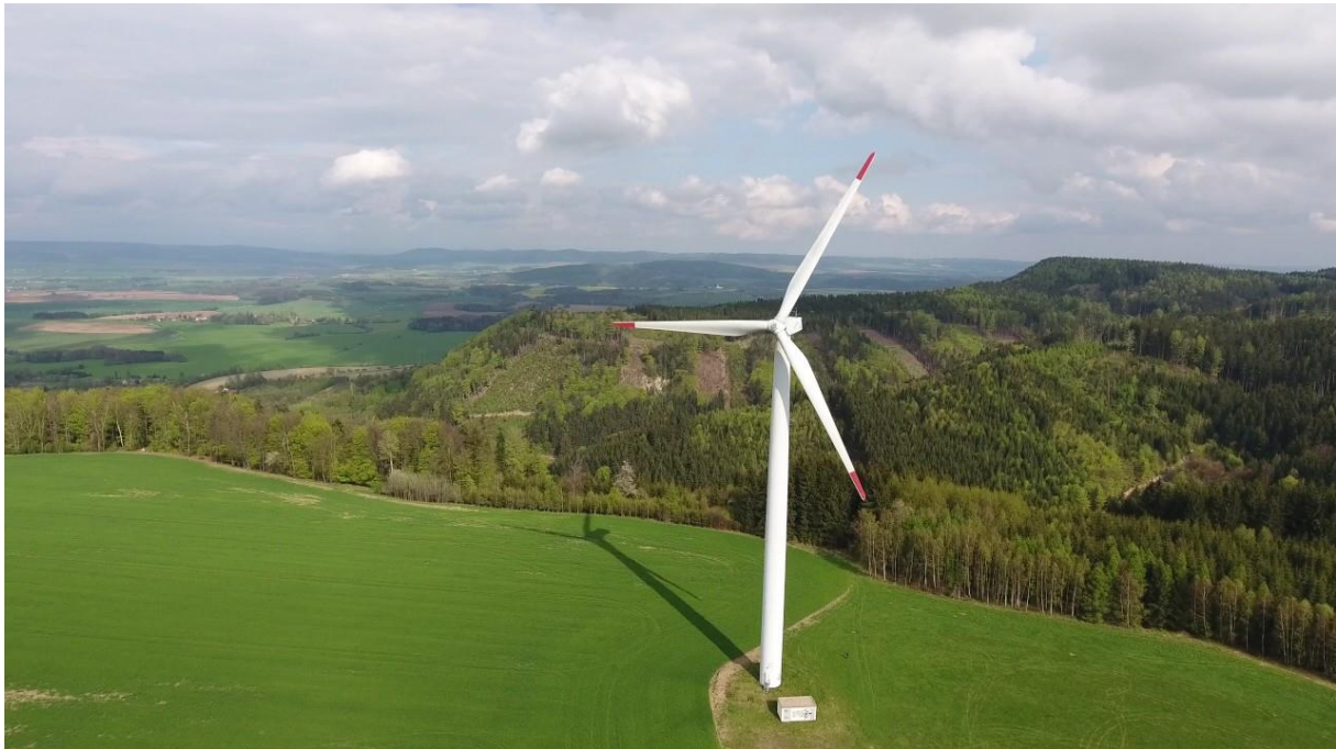
Slika 8: Postavljena vetrna elektrarna (vir: https://sl.magazinera.com/ )
