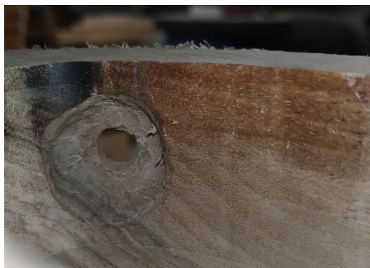
Slika 24: Luknja za električni priključek iz notranje strani. (Vir: Lastni)
