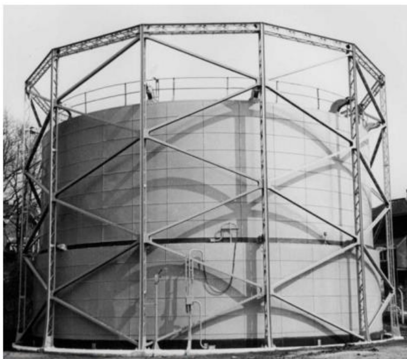
Slika 27: Gazometer s kovinskim ohišjem in betonskim rezervoarjem, Južna Anglija (Russell, 2010)
