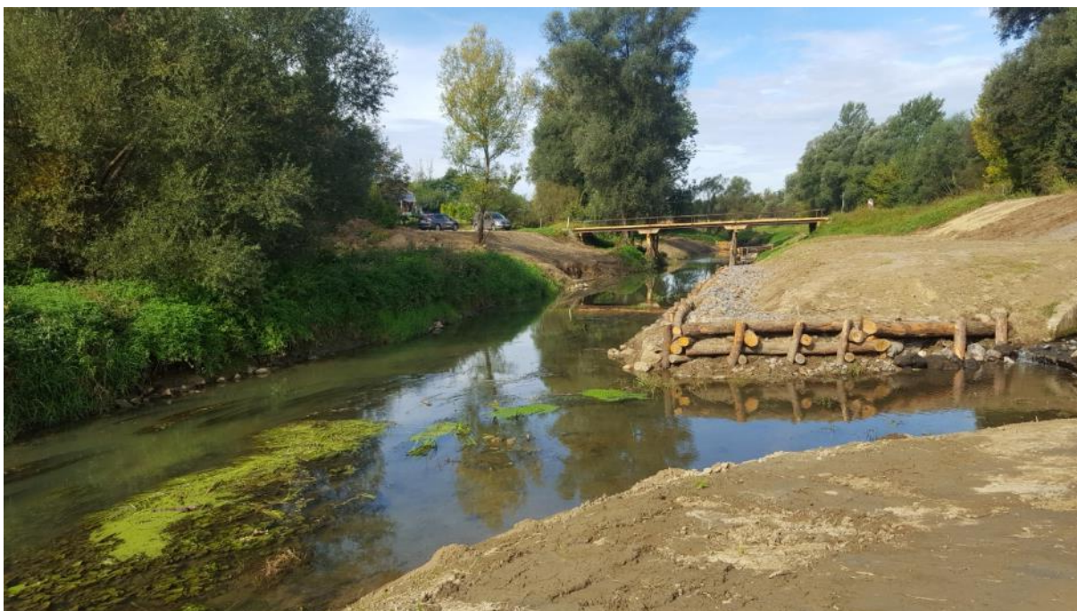
Slika 32: Zaliv v strugi Ščavnice in utrditev brežine proti poplavi (Vovk Korže, A. 2020)
