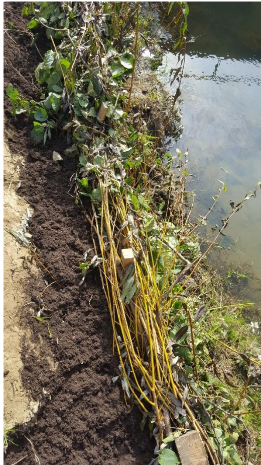
Slika 30: Vrbov poplet za varovanje brežin (Vovk Korže, A. 2020)
