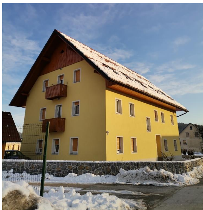
Fotografija 8: Večstanovanjska stavba, en vhod
