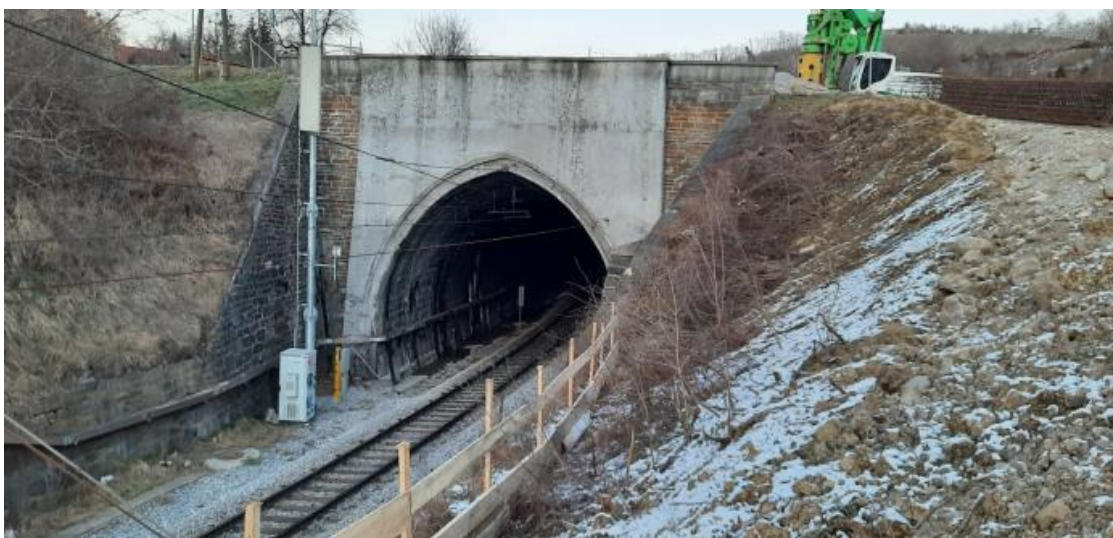
Slika 35: Železniški predor Počehova, 2021 (vir: lastna fotografija)
