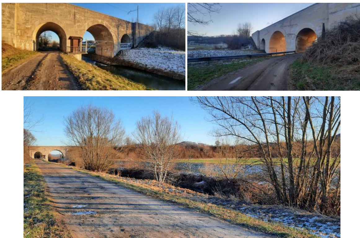
Slike 32, 33, 34: Pesniški viadukt, 2021 (vir: lastne fotografije)
