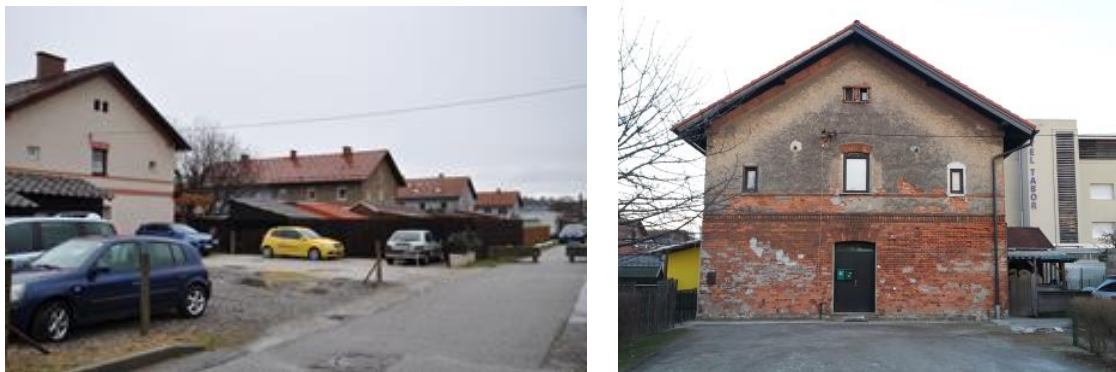
Sliki 60, 61: Hiše v železničarski koloniji, Wattova ulica, 2021 (vir: lastni fotografiji)
