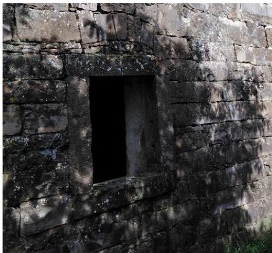
Slika 26: Kamniti okvir okna
