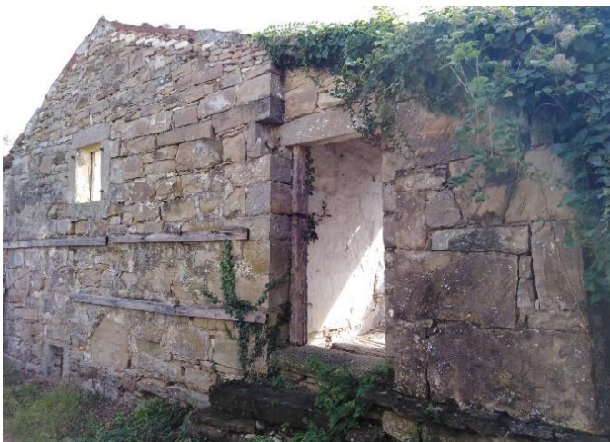
Slika 28: Preklada nad vrati
