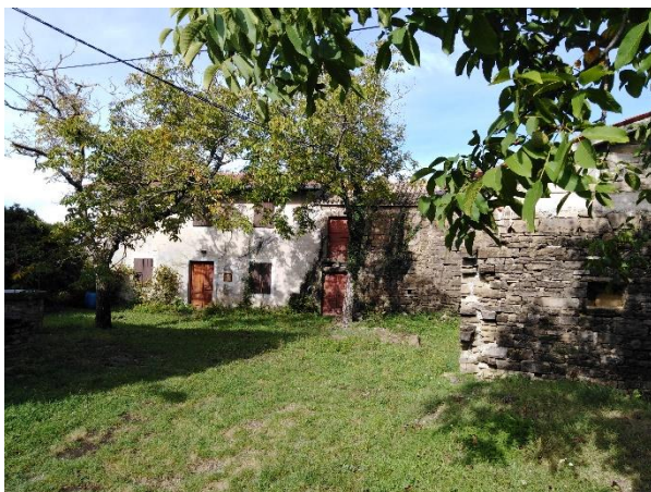
Slika 12: Hiša v postopku obnove
