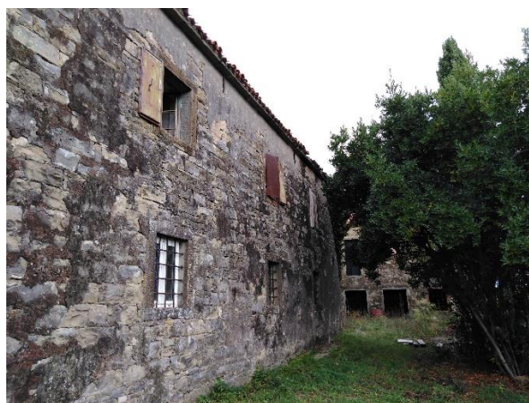
Slika 13: Hiša v postopku obnove
