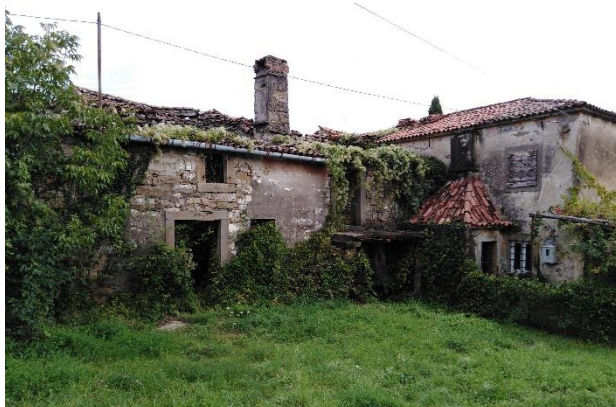
Slika 15: Istrska hiša v slabem stanju
