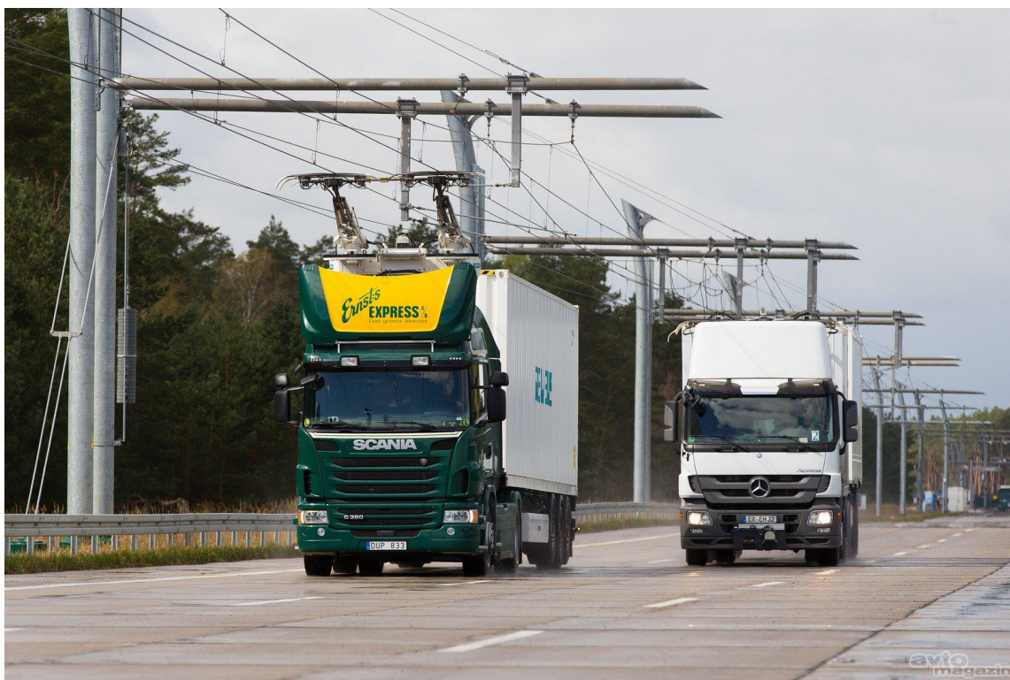
Slika 3: Odsek elektrificirane avtoceste v Nemčiji
